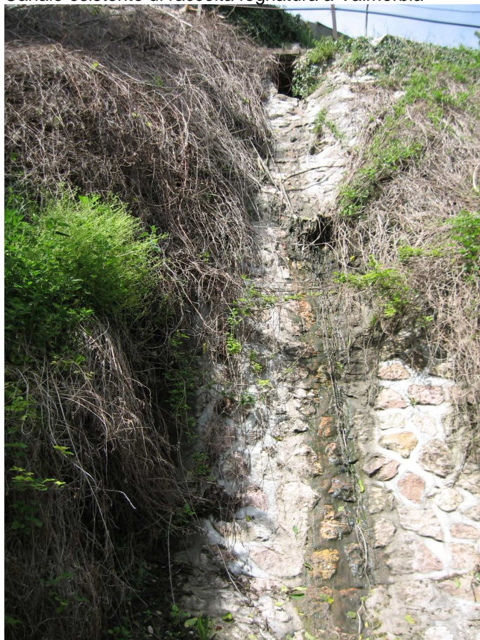
Canale esistente di raccolta fognatura a Valmorbia
