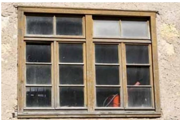
*Telaio a due ante con soprauce a due specchi*
