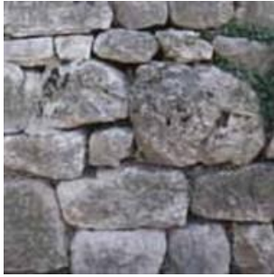
Muro a secco concio a spacco
