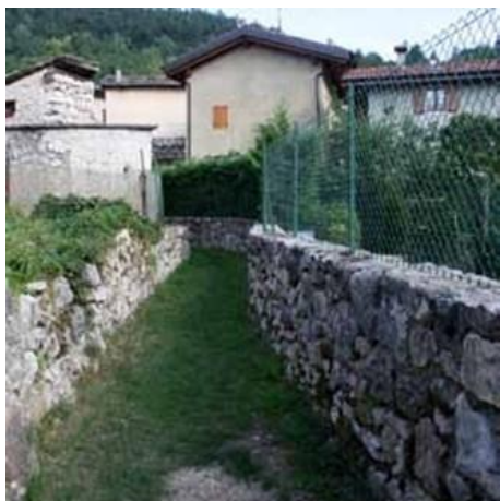
Muro di contenimento con recinzione per giardino
