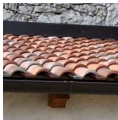
Manto di copertura in tegola di coppo
