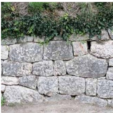
Muro di contenimento in blocchi squadrati in pietra locale
