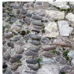
Acciottolato di diverse caratteristiche separato con ciotoli disposti in linea
