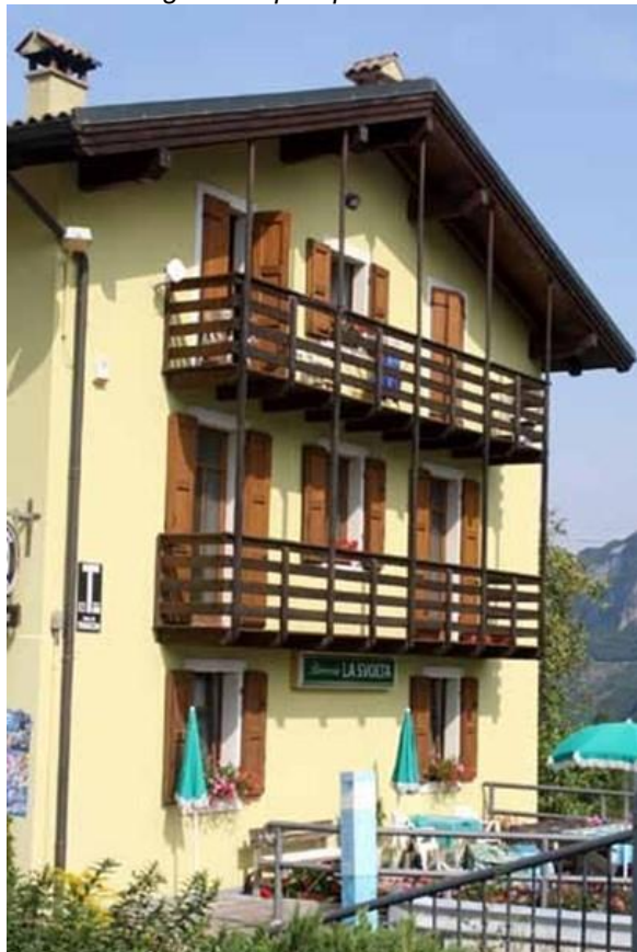
Balconi in legno con parapetto in assi orizzontali
