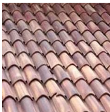
Manto di copertura in coppi
