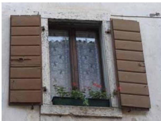
Interno con assi orizzontali
