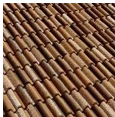
Manto di copertura in tegole in cemento
