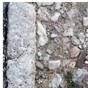
Lastra in pietra calcarea per segnare limite strada
