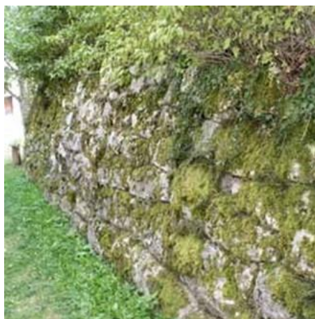
Muro di contenimento in blocchi di pietra locale a spacco disposto a nord
