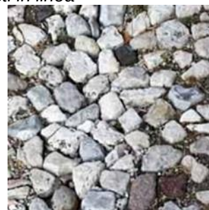
Acciottolato di diverse caratteristiche separato con ciotoli disposti in linea
