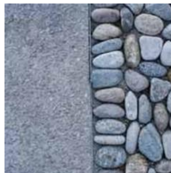
Acciottolato e calcestruzzo architettonico diviso con elemento in acciaio
