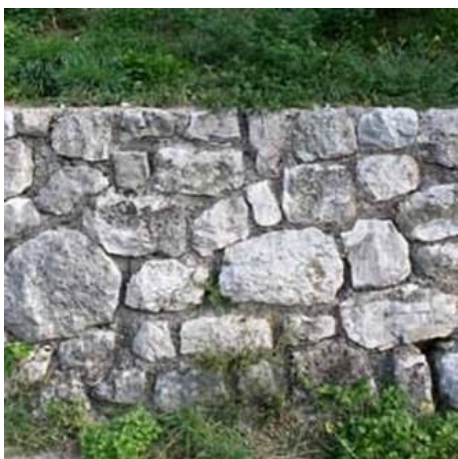
Muro di contenimento in blocchi di pietra locale a spacco
