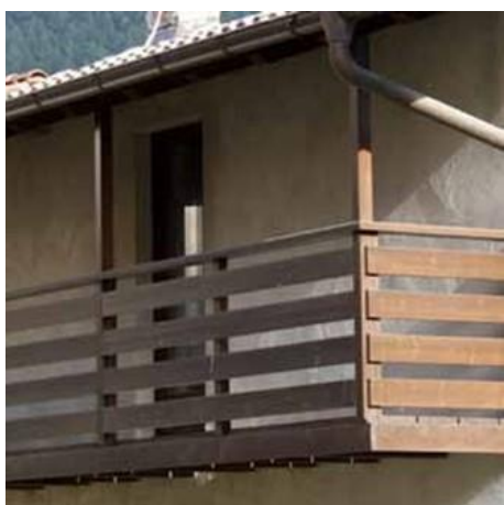
Ballatoi in legno assi orizzontali – montanti singoli
