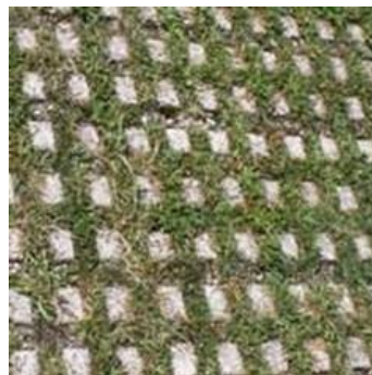
Grigliato in cemento inerbato
