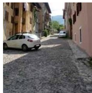
Pavimento in acciottolato con differenza di tonalità per segnalare il marciapiede
