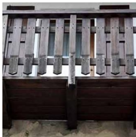
Balcone in legno assi verticali
