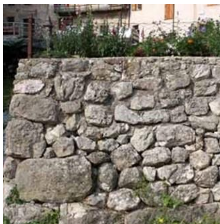
Muro di contenimento in blocchi di pietra locale a spacco con conci grandi
