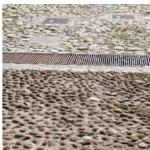
Uso di griglia di raccolta acque bianche per cambio pavimentazione
