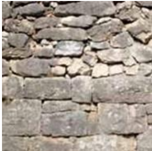
Muro a secco base conci squadrati Parte superiore conci posati in piano di dimensioni più ridotte
