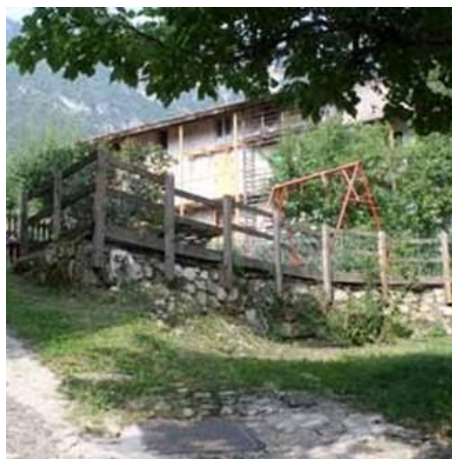
Muro di contenimento con recinzione in legno
