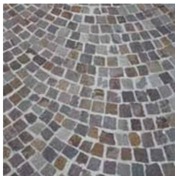
Cubetti di porfido posati a coda di pavone
